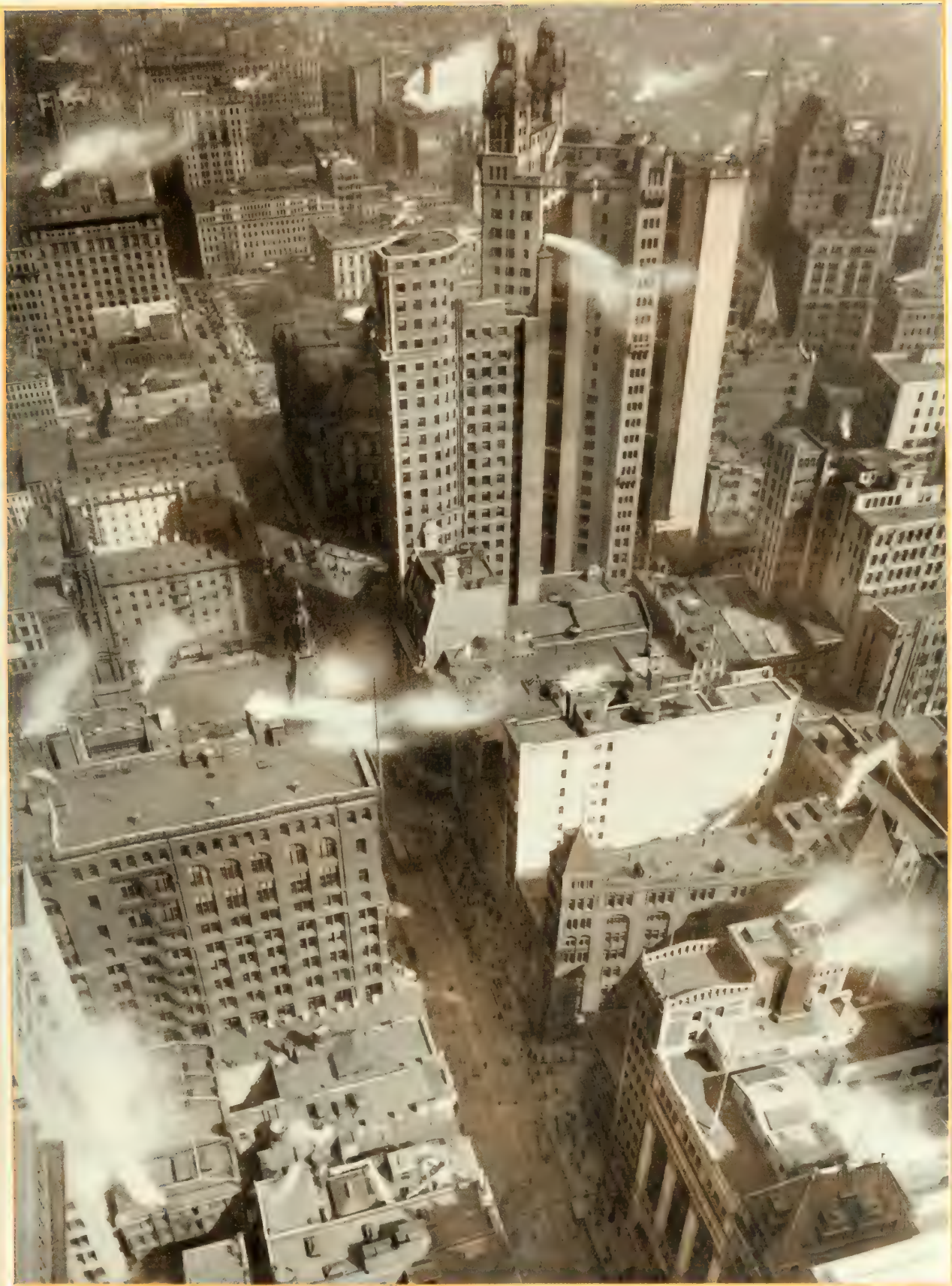
LES "GRATTE CIEL" — Ces maisons, d'une architecture assez banale, produisent, par leur entassement, une impression de grandeur et de réelle beauté, que ne saurait atténuer l'inévitable déformation photographique.
